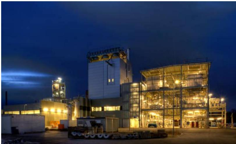
Die bioliq<sup>®</sup>-Anlage am KIT: In einem mehrstufigen Prozess entstehen aus Stroh und anderen biogenen Reststoffen hochwertige synthetische Kraftstoffe. (Foto: Markus Breig)
