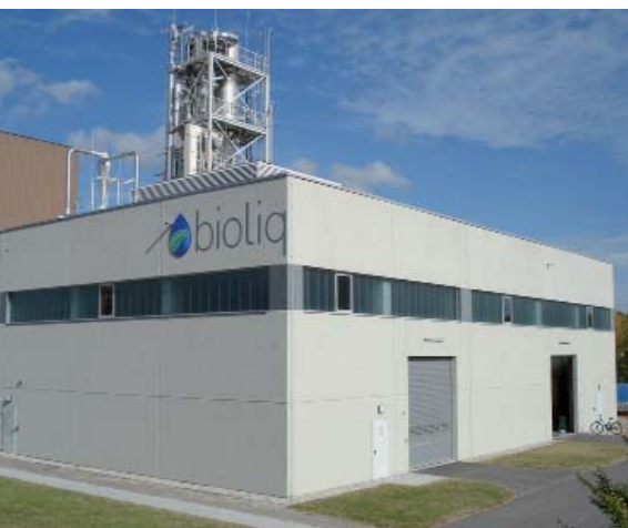
4 Prozessgebäude der Pyrolyse-Pilotanlage am KIT
