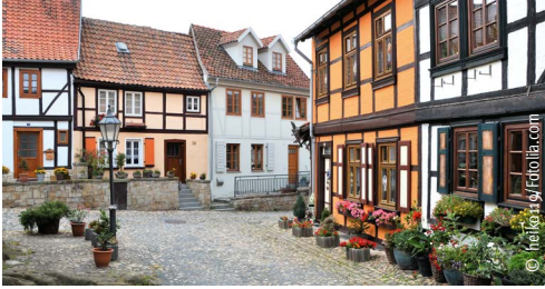
Naturbaustoffe sind die erste Wahl für die Sanierung von historischen Gebäuden
