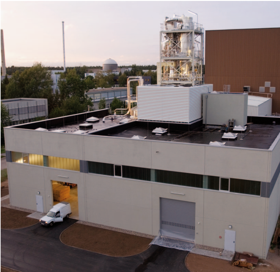
Das Gebäude der bioliq®-Pilotanlage auf dem KIT-Campus Nord. Im Hochdruck-Flugstromvergaser wird ein Slurry zu Synthesegas umgesetzt.
