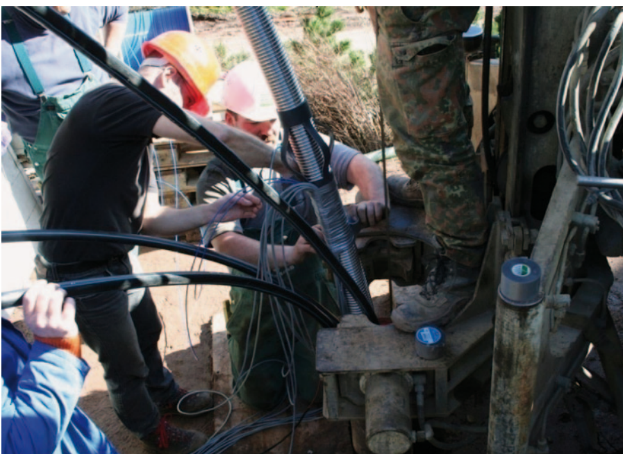
Tiefe CO 2 -Erdwärmesonde am Standort Nussbach im Nordschwarzwald.
